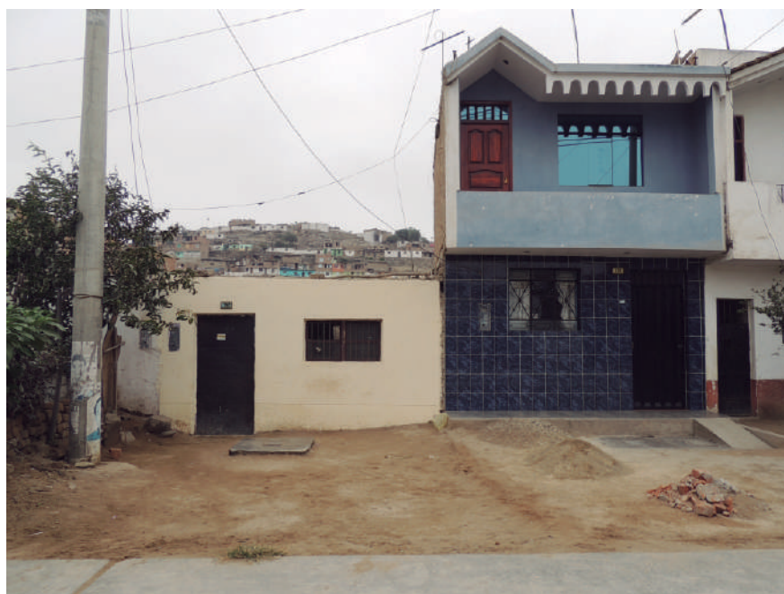
El Porvenir: Sector Río Seco I
