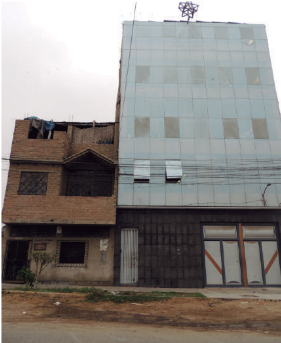
El Porvenir: Sector Río Seco I
