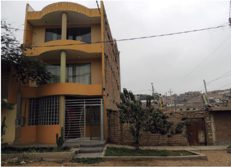
El Porvenir: Sector Río Seco I
